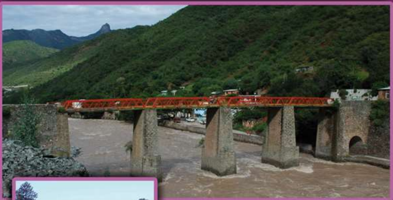
Métodos para el cálculo de la socavación local en pilas de puentes
