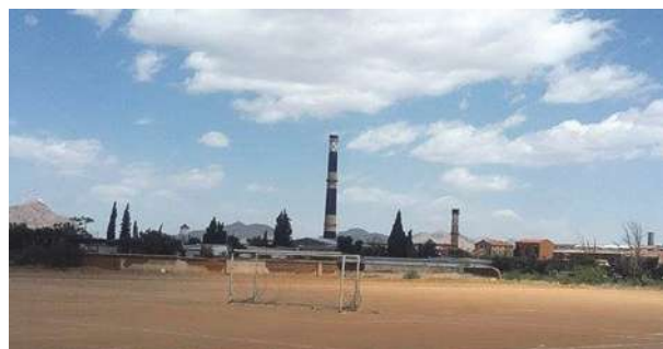
Figura 1. Fundición de Avalos Chihuahua (1905-1993). Ahora abandonada, operó como beneficiadora de plomo, plata y zinc con una capacidad para 250 toneladas diarias.
