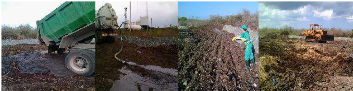
Figura 1. Ejecución del proceso. De izquierda a derecha: Adición de los cortes, lodo activo, urea y mezclado del suelo
