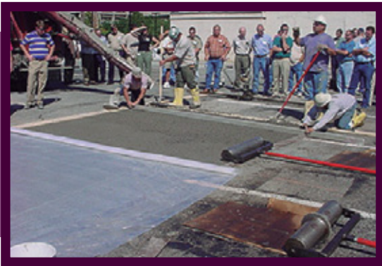
Figura 2. Curado del concreto permeable
