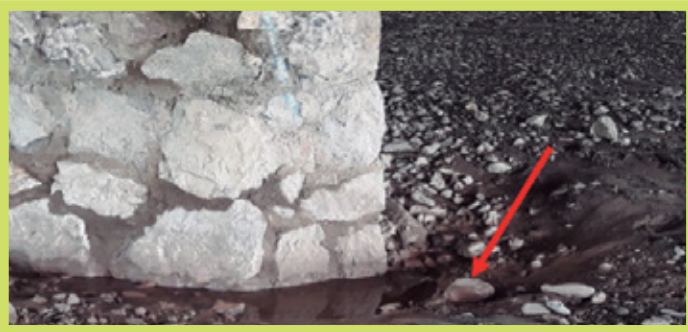
Figura 2. Socavación local moderada en columna de un puente.
