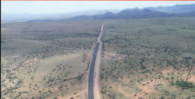
MODERNIZACIÓN MEDIANTE LA AMPLIACIÓN DE LA CARRETERA DURANGO - PARRAL, TRAMO SAN JUAN DEL RÍO - MATAMOROS.
