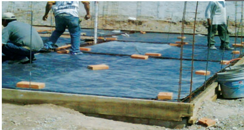
Figura 2.- Implementación de sellado y tubería de ventilación en nueva vivienda.
