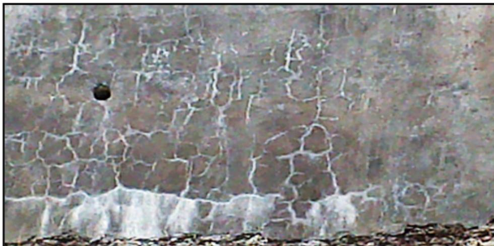
**Figura 1.** Muro de contención afectado por la RAA.
