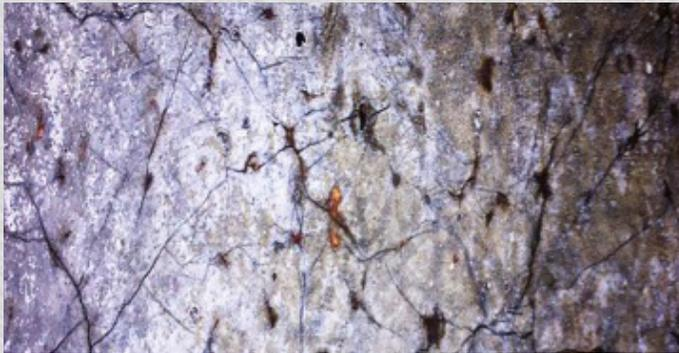
Figura 1. Fisuramiento en el concreto producto de la RAA.
