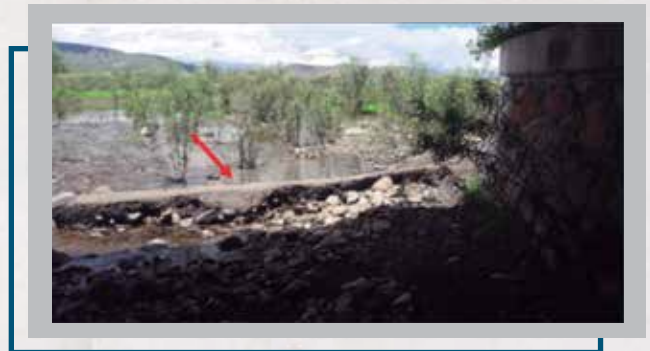
Figura 5. Realización de dique para la contención del agua (Jiménez, 2012).
