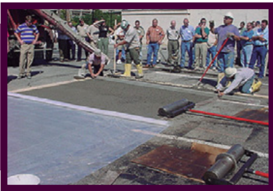
Figura 2. Curado del concreto permeable
