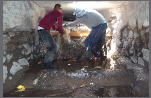
Figura 5. Tramo embovedado antiguo, con azolve
